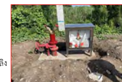
ระบบท่อน้ำดับเพลิงบริเวณลานกองก่อนใบอ้อย
